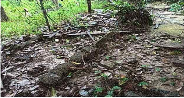
Reparacion de Muro
