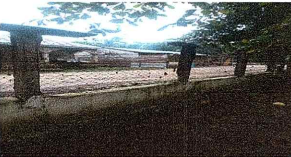
Reparacion de muro dañado
