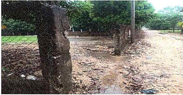
Porton de metal de 3.80 de largo x 1.80 de ancho
